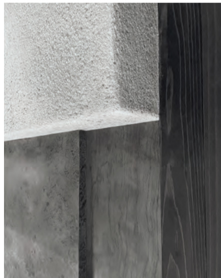
土壁、緑青、ブビンガ、黒染杉板
