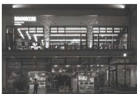
地上からの外観
