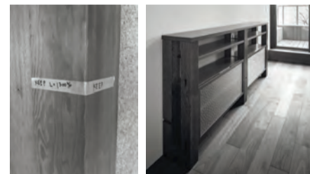
解体前に選定した材をキャビネットに使用
